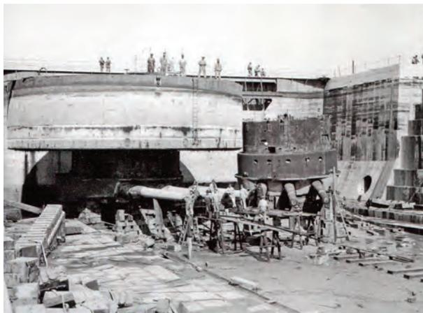
Due delle tre torri trinate di G.C. del *DA VINCI* in demolizione all'interno del bacino n. 2 dell'Arsenale di Taranto. La torre sulla sinistra è ancora agganciata, tramite i penzoli di catena, al galleggiante anulare che l'ha sollevata dal fondo (USMM).
